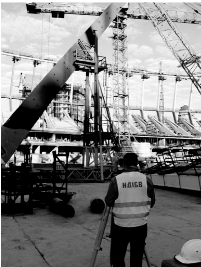
Рис. 4 Проведення геодезичних робіт при складанні колони
